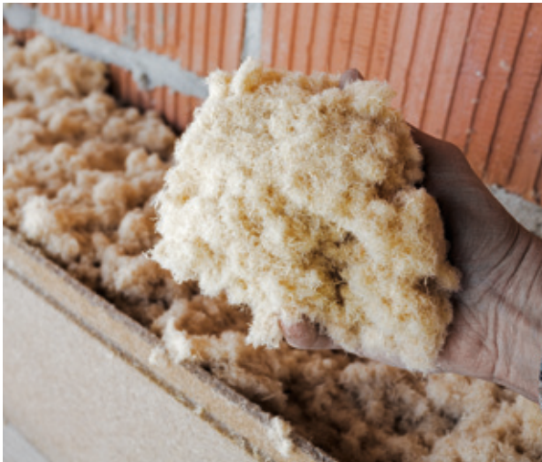
Holzweichfasern für die formatvariable Wärmedämmung von Hohlräumen
