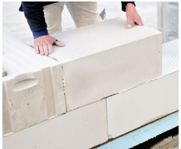
Mauerwerk aus Porenbeton-Plansteinen
