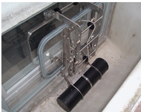
Automatisch schließende Vorsatzscheibe
