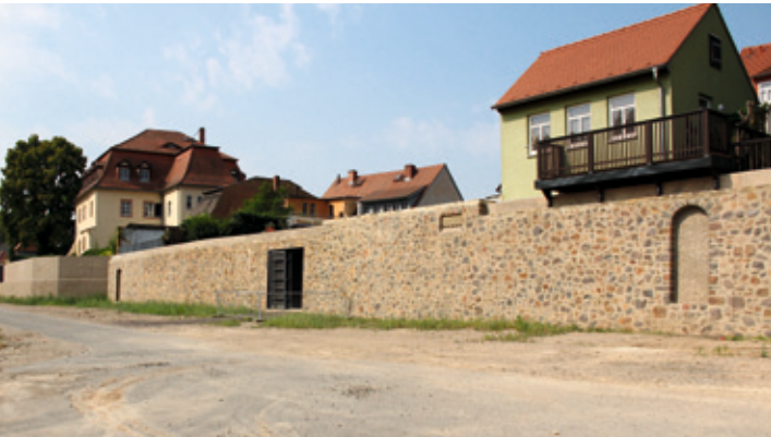
Integrierter Hochwasserschutz in der historischen Stadtmauer ...
