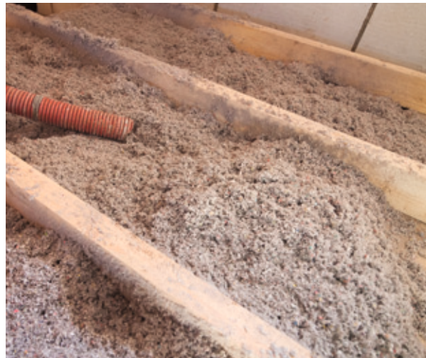
Anwendung von Zelluloseflocken im Fußbodenbereich
