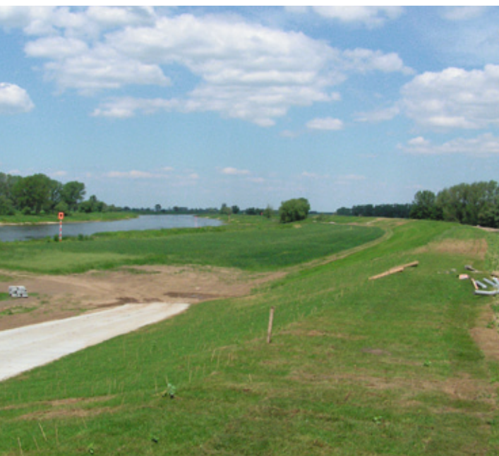
Sanierter Hochwasserschutzdeich an der Elbe
