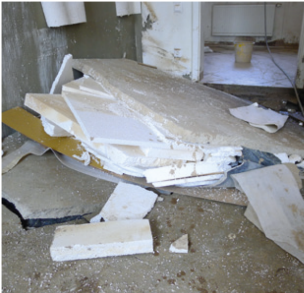
Aufgeschwommene Fußbodenkonstruktion
