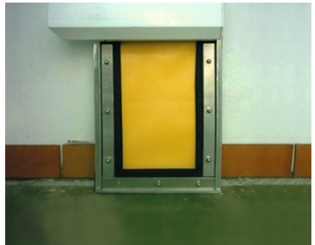
Folienabdichtung für Gebäudeöffnungen
