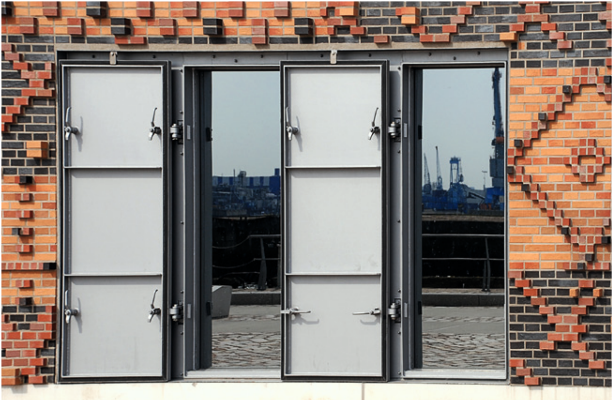
Integrierte Flutschutztüren
