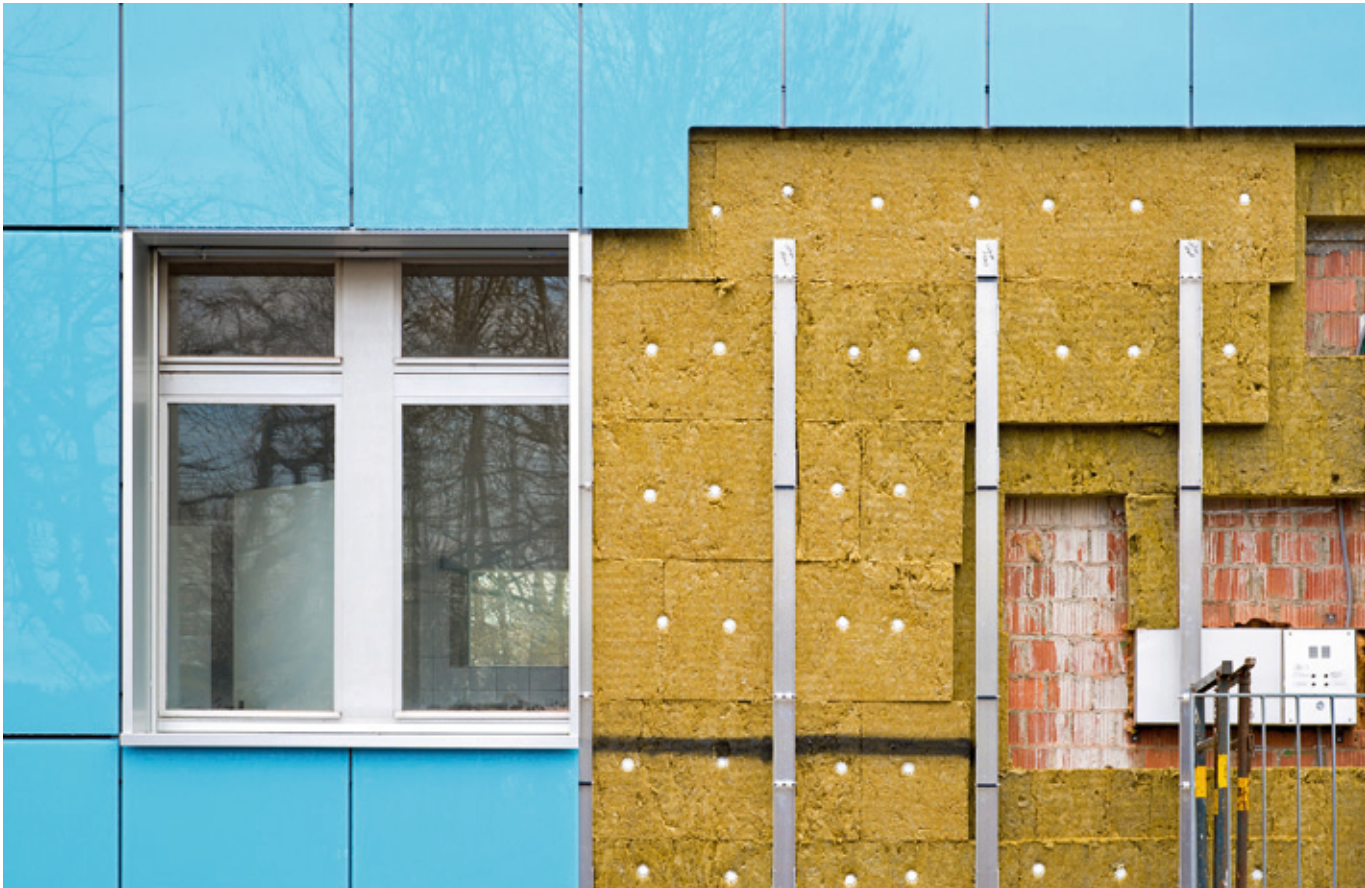
Hinterlüftete Fassadenkonstruktion
